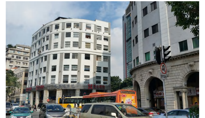
广州越秀区九小场所消防整改项目
