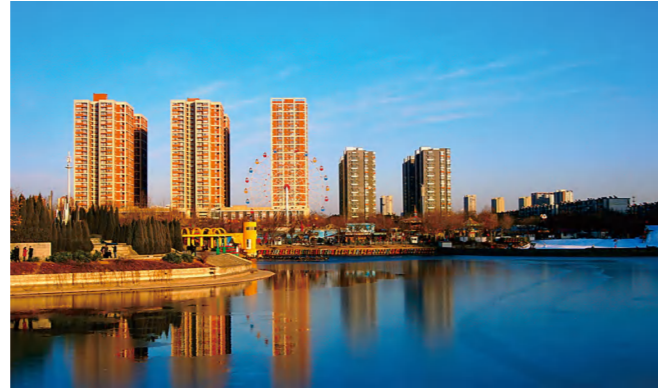
石家庄煤改气燃气报警器项目
