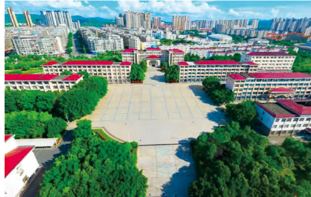
江西南康燃气改造项目
