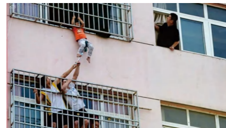
武汉市江夏区北华街古驿道一栋民房5楼，4岁10个月的男童子皓独自在家攀爬窗户，从防盗网缝隙中落下，头部被卡在防盗网两根钢柱之间，身体悬空，随时可能坠落。
