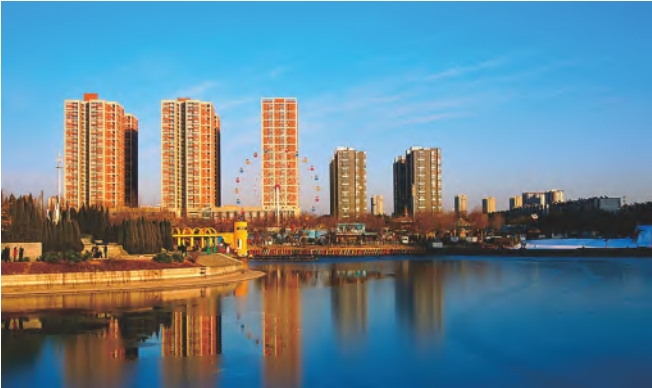
石家庄煤改气燃气报警器项目
