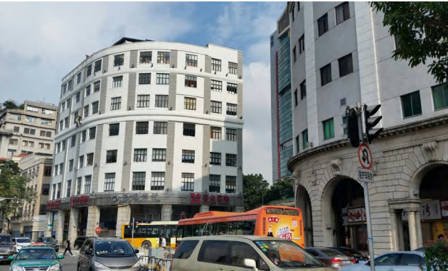
广州越秀区九小场所消防整改项目
