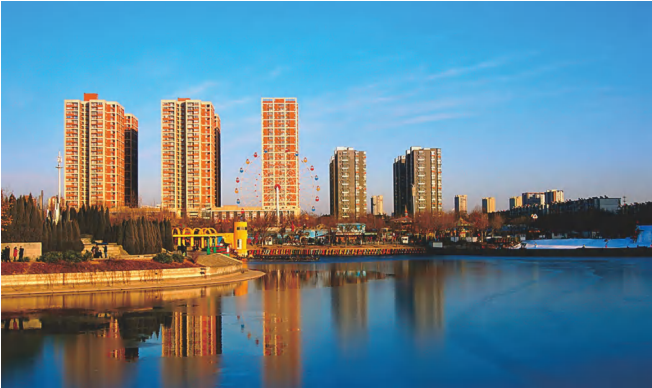
石家庄煤改气燃气报警器项目
