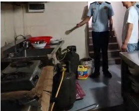
地下室需联动排风扇
