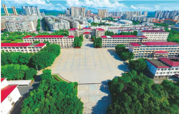
江西南康燃气改造项目
