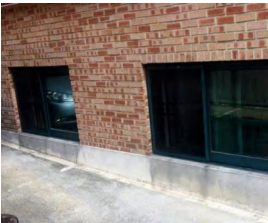
半地下室联动排风扇
