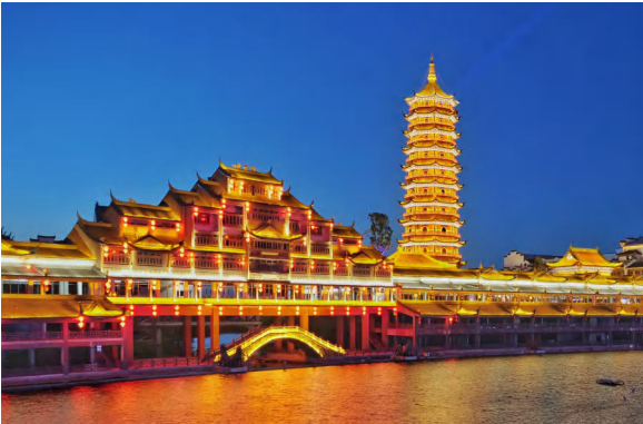
浙江省绍兴市嵊州桥李村项目
